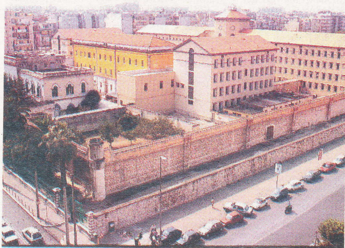
IL CARCERE A Bari sovraffollamento di detenuti e sottorganico di agenti
